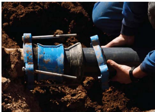
Ouvrier qui répare une pipe d'eau dans une rue en construction
