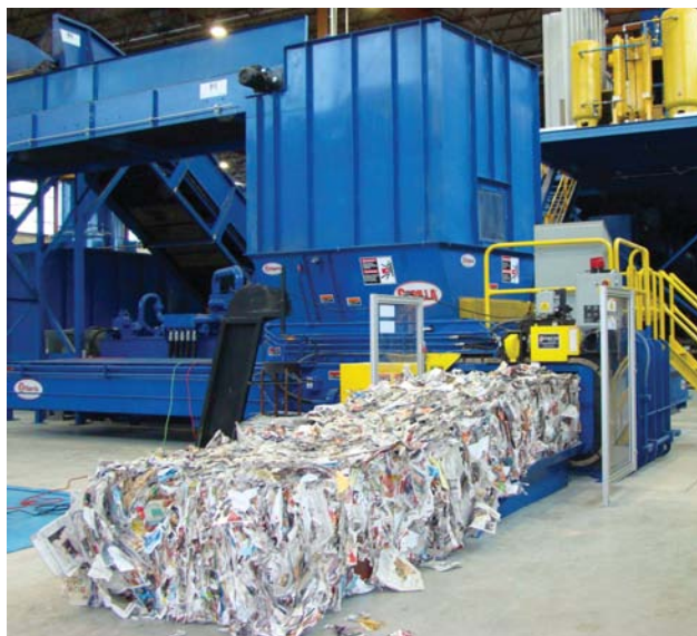
Installation de récupération des matières – Durham, Ontario
