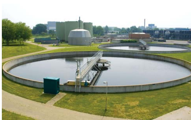
Station de traitement d'eau potable
